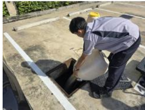
รูปที่ 57 เจ้าหน้าที่ดำเนินการเติมจุลินทรีย์ บริเวณบ่อบำบัดน้ำเสีย
