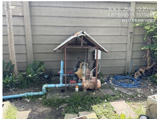
รูปที่ 14 ระบบน้ำทิ้งที่ผ่านการบำบัดแล้วมาใช้รดน้ำต้นไม้
