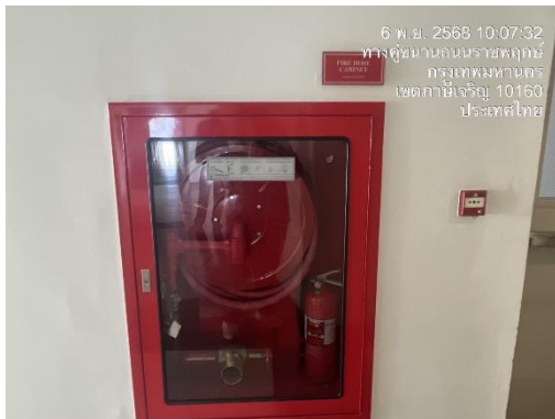
รูปที่ 38 ตู้เก็บสายฉีดน้ำดับเพลิง
