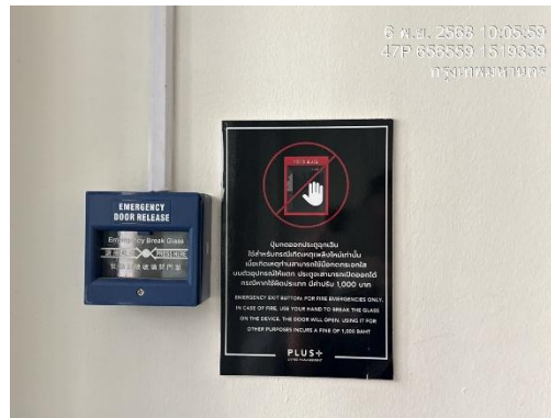
รูปที่ 23 ระบบเปิดประตูทางออกเมื่อเกิดเหตุฉุกเฉินเท่านั้น
