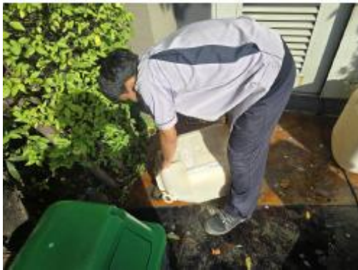
รูปที่ 57 เจ้าหน้าที่ดำเนินการเติมจุลินทรีย์ บริเวณบ่อบำบัดน้ำเสีย
